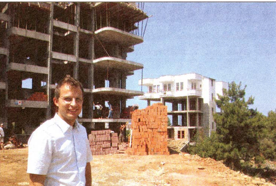
ELVBYG: Bo Thygesen og hans firma er begyndt selv at bygge lejligheder. Betonbyggeriet skal om få måneder stå færdigt som 21 lejligheder.
